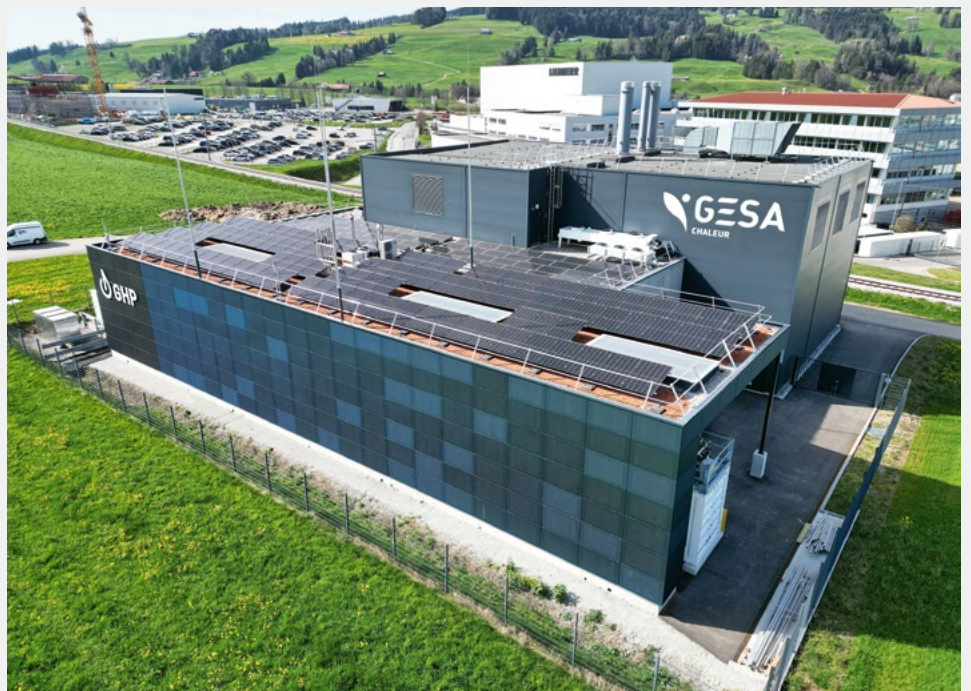
Fig. 2 Wasserstoffproduktion der Gruyère Hydrogen Power SA (GHP) in Bulle.
