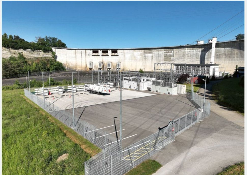
Fig. 1 Wasserstoffproduktionsstätte der Groupe E an der Schifflenenstaumauer.
